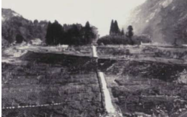
断層のずれにより、写真中央の道路が寸断している(当時撮影)(本巣市) 写真撮影:小藤文次郎氏
