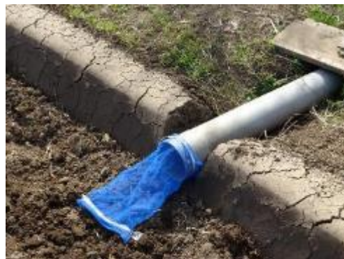
取水口への網の設置
